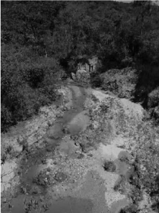
Figura 10: Assoreamento no Córrego do Quebra.
