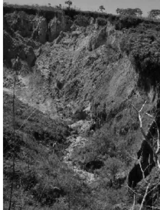
Figura 9: Borda de Voçoroca sem cobertura vegetal.
